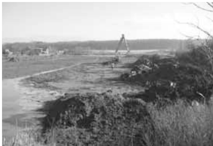
Úprava rybníku Močidlo v Lodíně.
