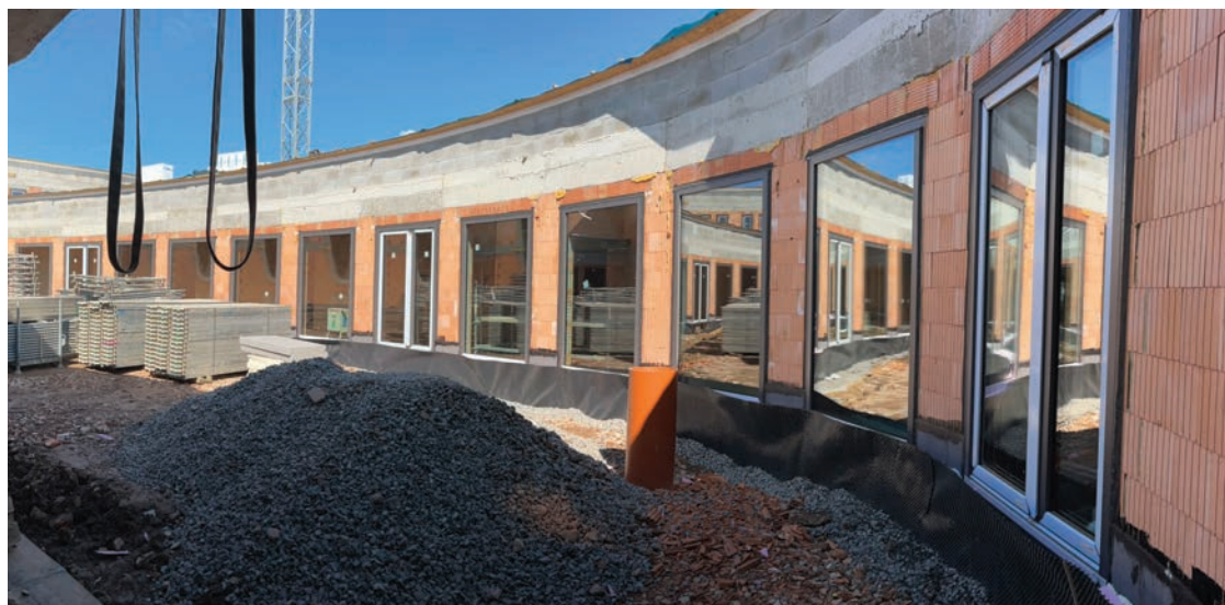
■ Po dokončení hrubé stavby probíhají především vnitřní práce. – Foto: Natalie Medová
