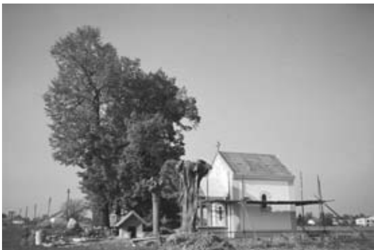
Mžany - kaplička se studánkou v době rekonstrukce.
